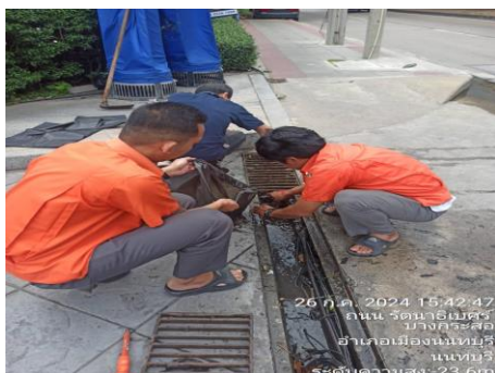
การทำความสะอาด ขุดลอกบ่อพักน้ำ บ่อพักขยะบ่อหน่วงน้ำโครงการ
