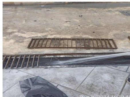
การทำความสะอาด ขุดลอกบ่อพักน้ำ บ่อพักขยะบ่อหน่วงน้ำโครงการ
