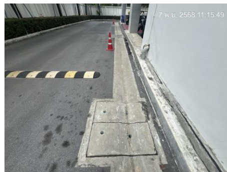
บ่อพักน้ำก่อนระบายออกนอกโครงการ
