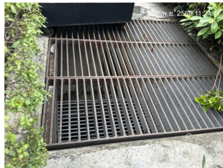
บ่อพักน้ำก่อนระบายออกนอกโครงการ
